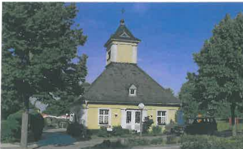
Bild 15: Transformatorstation von 1926 wurde zum Cafe in Bad Rappenau (BW), Saline 1,2,3 Foto: Illo-Frank Primus
