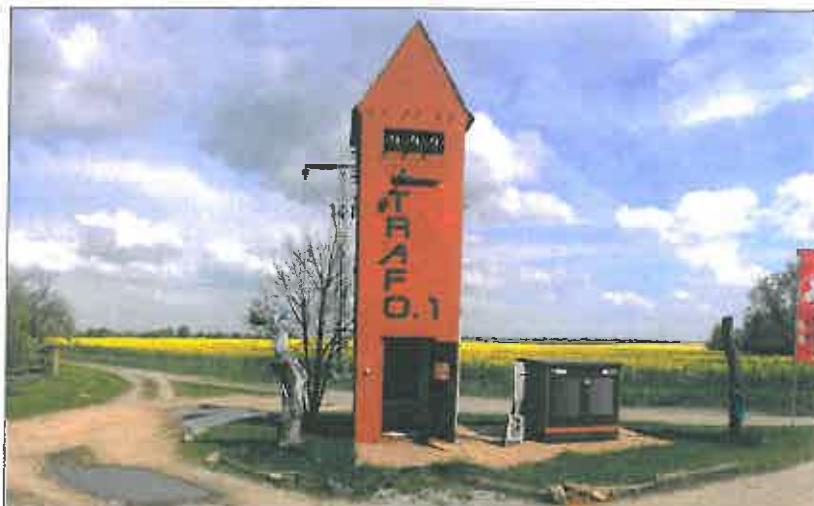
Bild 6: Transformatorstation von 1952 wurde zur »Galerie Regenmantel« in Falkenhagen-Regenmantel (BB)
