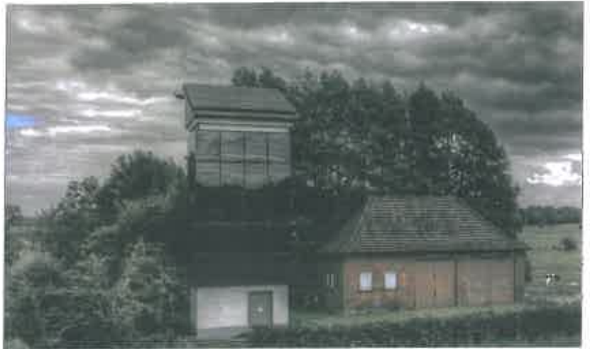
Bild 16: Transformatorstation von 1933 wurde zum Solarkraftwerk in Kranenburg-Wyler (NW), Alte Heerstr. 72
