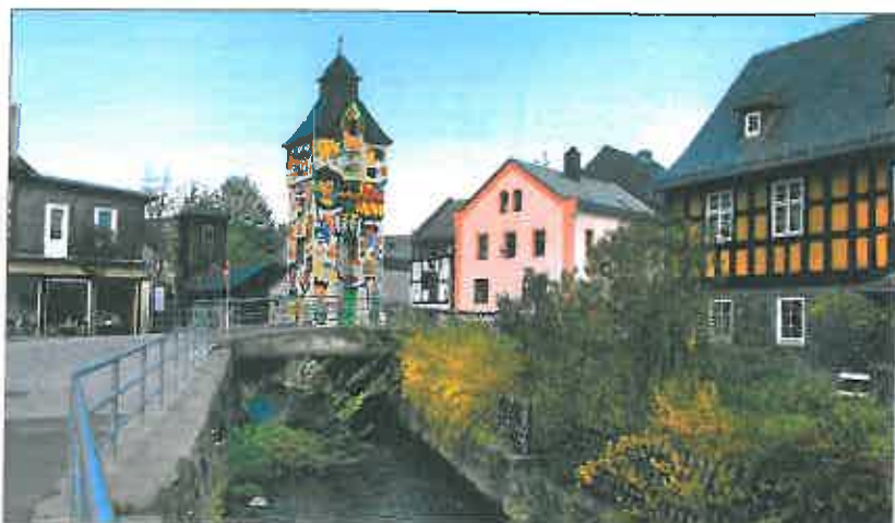
Bild 3: Transformatorstation von 1915 wurde zum Kunstobjekt des Künstlers Fischer-Art in Wurzbach (TH), Markt
