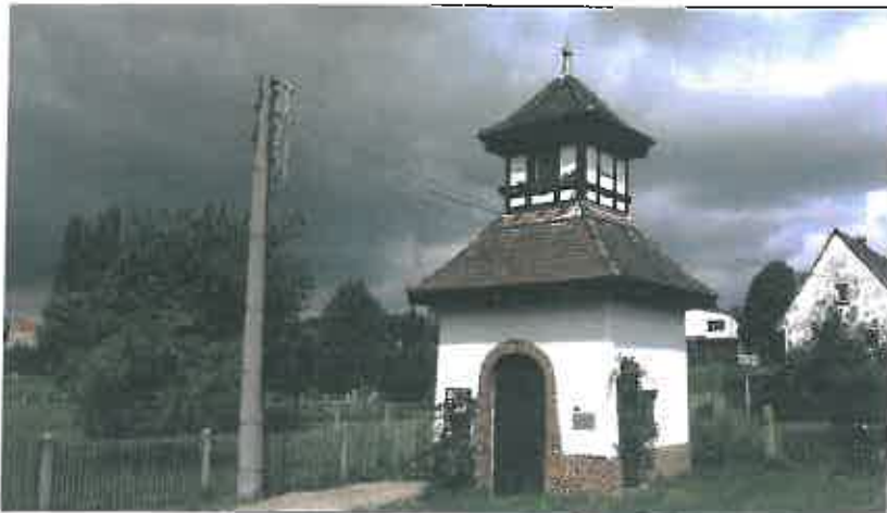
Bild 1: Transformatorstation Typ »Chinesentempel« wurde zum Tierhotel in Niederfrankenhain (SN), vom NABU Sachsen betreut [7]
