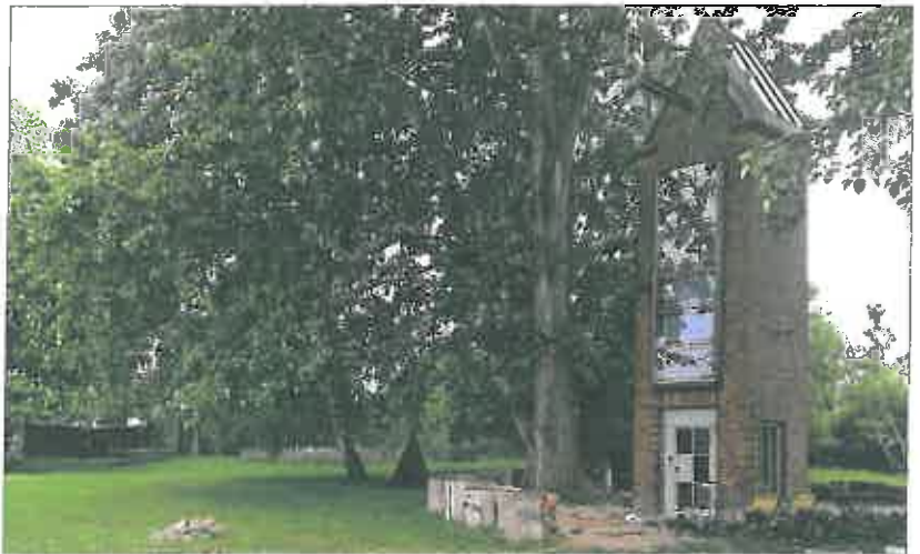
Bild 10: Transformatorstation von 1950 wurde zum »Kinderhotel und Spielturm« in Nakenstorf (MV), Seestr. 1
