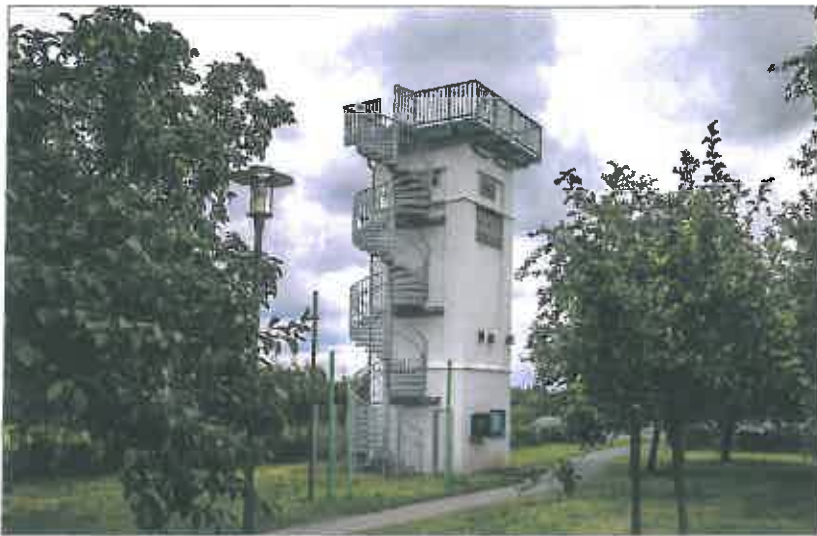
Bild 14: Transformatorstation wurde zum Aussichtsturm in Bislicher Insel (NW) Foto: Alfred Derks
