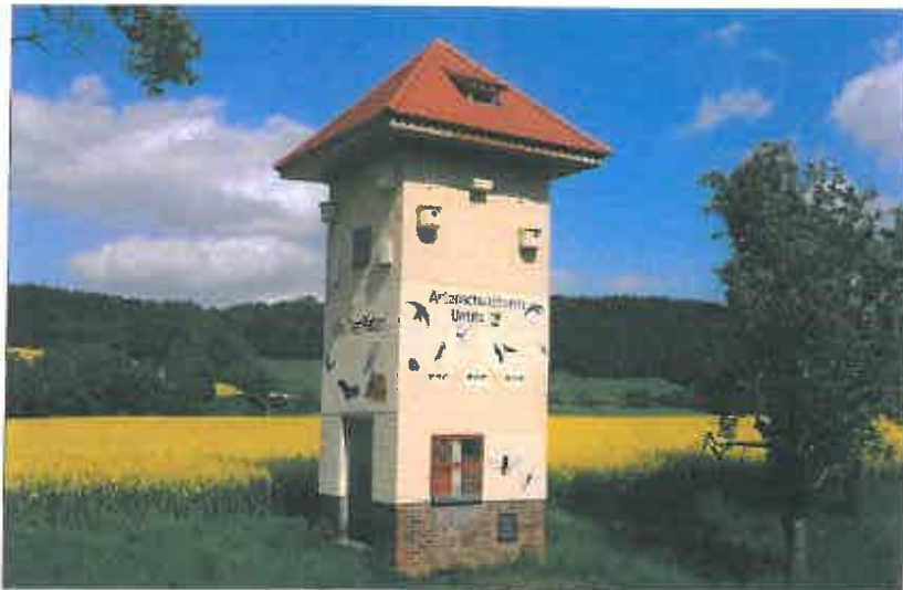
Bild 2: Transformatorstation wurde zum Artenschutzurm in Wünschendorf-Untitz (TH), von der Stiftung Pro Artenvielfalt betreut [8]
