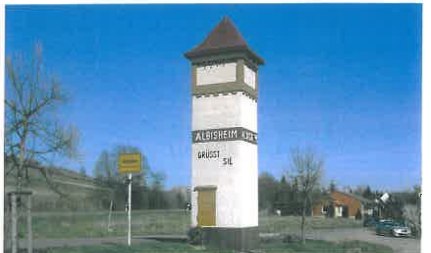
Bild 18: Transformatorstation wurde zum Botschafter in Albisheim (RP), Ortseingang
