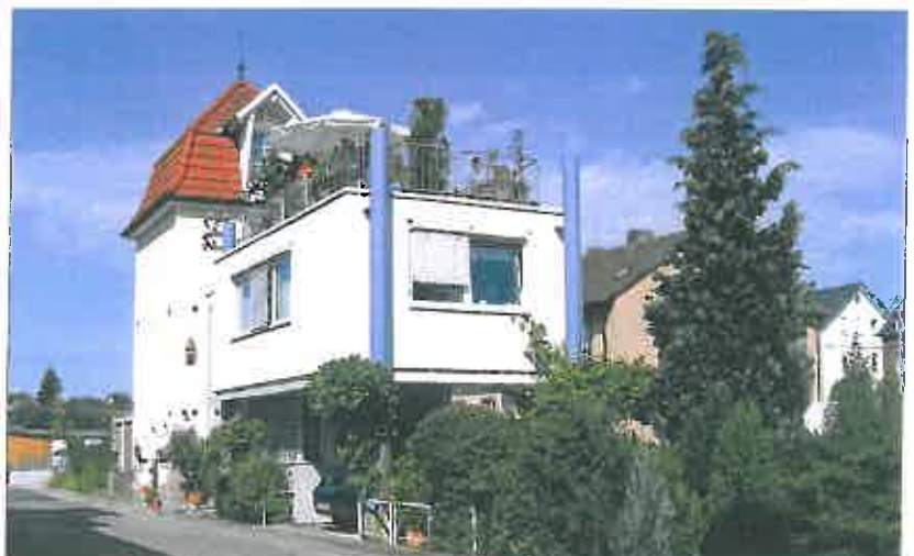
Bild 12: Transformatorstation von 1922 wurde zum Wohnhaus in Neustadt/Coburg (BY), Angerweg 8
