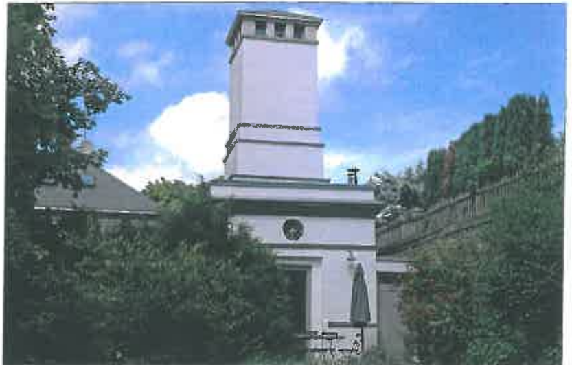
Bild 11: Transformatorstation von 1925 wurde zum »Hotel Trafohaus« in Solingen (NW), Garnisonstr. 26
