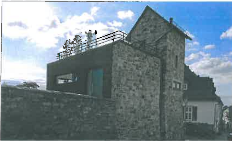
Bild 13: Transformatorstation wurde zum Wohnhaus in Idstein (HE), Obergasse Foto: www.guckes-kollegen.de, Gerhard Guckes
