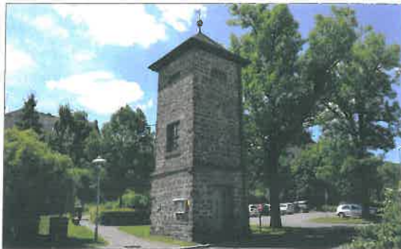
Bild 4: Transformatorstation von 1919 wurde zum »Isolatorenmuseum« in Lohr (BY), Haagasse
