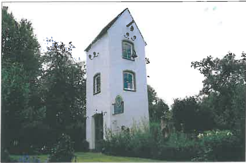
Bild 8: Transformatorstation von 1954 wurde zur »Villa Ampere« in Leipzig (BY), Wissmannstr. 9
