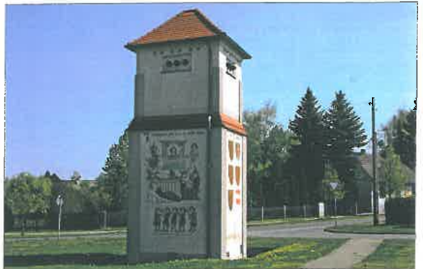
Bild 17: Transformatorstation von 1910 wurde zum Wahrzeichen in Repichau (ST), Akener Str., am Darfteich
