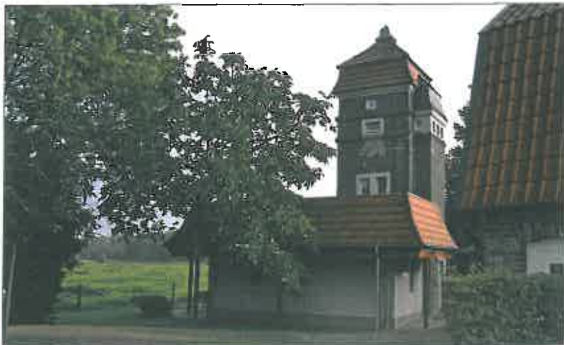
Bild 9: Transformatorstation wurde zur »Hochzeits-Turmsuite Isabel« in Weeze-Wissen (NW), Schlossallee 21
