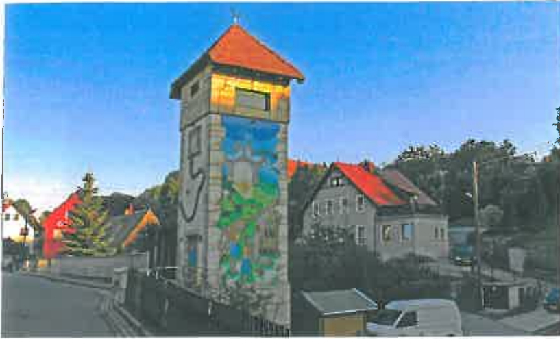
Bild 7: Transformatorstation wurde zum »Märchenturm« in Hohnstein-Ullersdorf (SN), Dorfstr. 33
