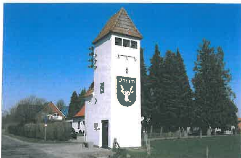
Bild 5: Transformatorstation von 1911 wurde zum »Elektromuseum« in Schermbek (NW), Zum Eisenberg
